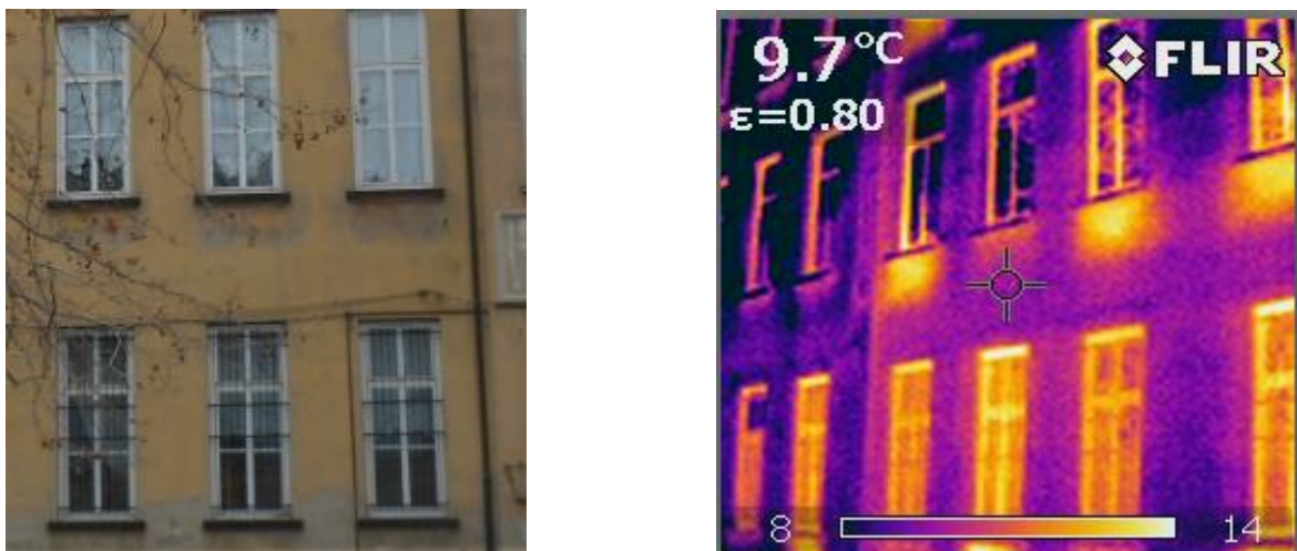
Figura 4.3 – Rilievo termografico della parete
