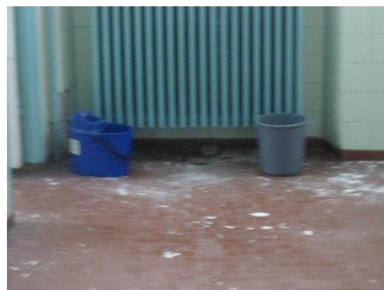
Figura 4.6 – Particolare dei radiatori
